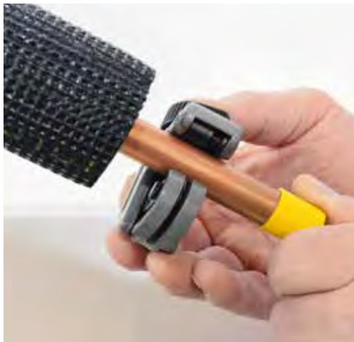
1. Ablängen der Leitung
